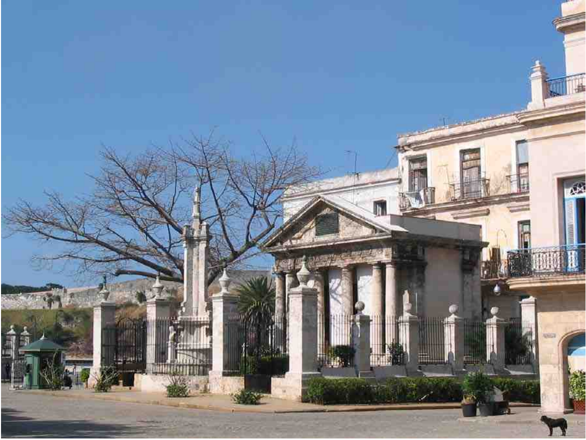
Figure 43. Antonio Mar a de la Torr , El Templete , Plaza de Armas, Havana, 1828
